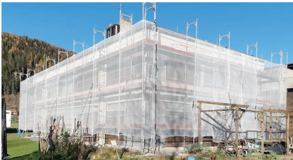
Die im Jahre 1971 fertiggestellte, teilweise aus Sichtbeton bestehende Fassade wurde für die Sanierung vollständig eingerüstet.
