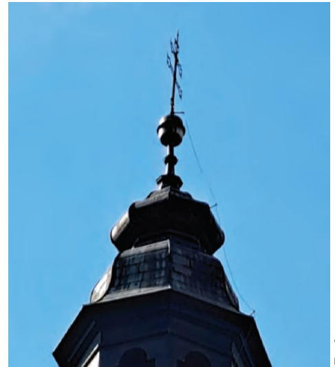
Deutlich sichtbar: Sturmschäden am Turmkreuz von St. Jakob
